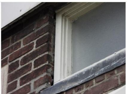
Foto 2.9: Holte naast kozijn, geschikt voor vleermuizen de spouwmuur in te komen
