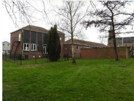
Foto 2.4: te slopen bebouwing, achterzijde (oostelijk deel)
