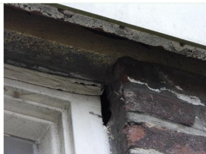
Foto 2.8: Holte naast kozijn, geschikt voor vleermuizen de spouwmuur in te komen
