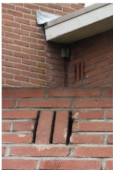
Foto 2.13: Meerdere ventilatie sparingen geschikt voor vleermuizen om de spouwmuur binnen te komen
