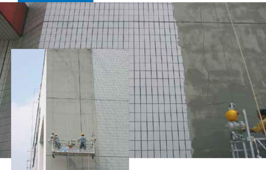
Aanbrengen van Planitop 200 op een keramische bekleding
