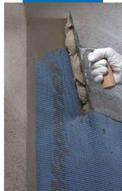
Aanbrengen van de tweede laag Planitop 200 over Mapenet 150 op verschillende soorten ondergronden
