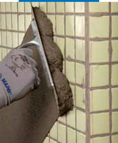
Aanbrengen van Planitop 200 op glasmazaïek
