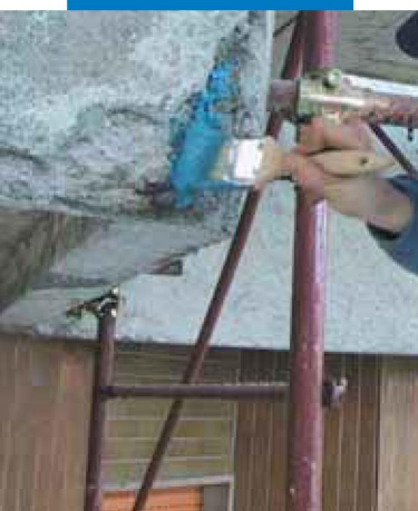
Met een kwast aanbrengen van Mapefer 1K op de wapeningsijzers van een balkon van gewapend beton
