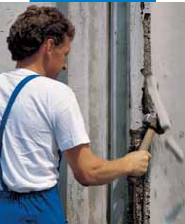
Verwijderen van aangetast beton
