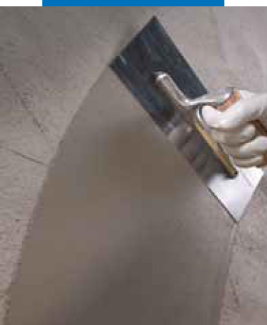
Aanbrengen van Planitop 200 op beton
