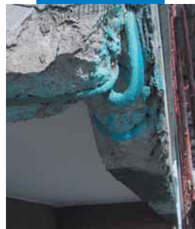
Wapeningsijzers van het front van een balkon, die behandeld zijn met Mapefer 1
