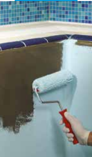
Aanbrengen van Elastocolor Waterproof met een roller
