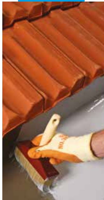
Details van een goot, waterdicht gemaakt met Mapelastic Smart en afgewerkt met Elastocolor Waterproof
