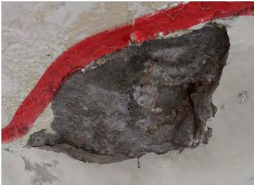
Figuur 4.7: Oorspronkelijke reparatie tot aan de wapeningsstaaf
