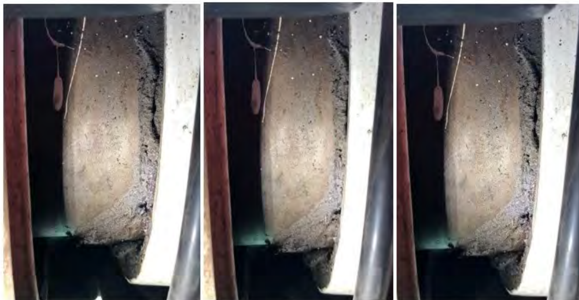
Figuur 5.5: Verplaatsing van een dwarskrachtbeugel bij passage van een vrachtwagen (links is op 0 sec, midden op 3 sec en rechts op 6 sec)
