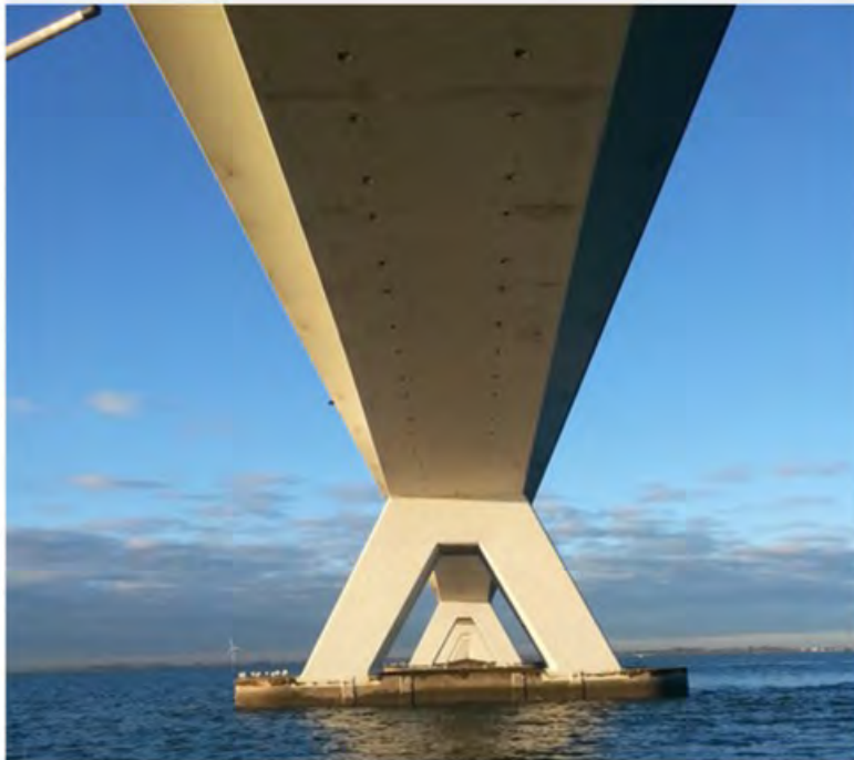
Figuur 1.1.3 Onderzijde brug
