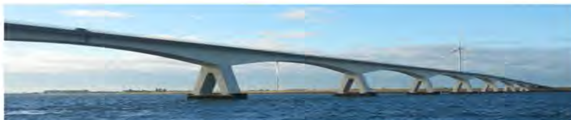
Figuur 1.1.2 Aanzicht brug
