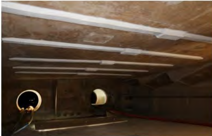
Figuur 4.9: Overzicht additionele dwarsvoorspanning
